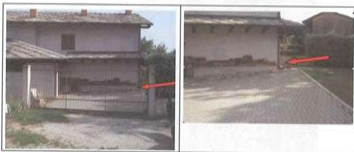
Questo fabbricato è inaccessibile ma lo spigolo è collimabile. È possibile proporre un RA anch'esso collimabile (piede dello spigolo su marciapiede in piastrelle) ed è realizzabile una buona intersezione in avanti attraverso le sbarre del portone. Non vi sono altri elementi sulla verticale dello spigolo e il tetto è inutilizzabile (orditura in legno e inoltre coperto dalla falda).
