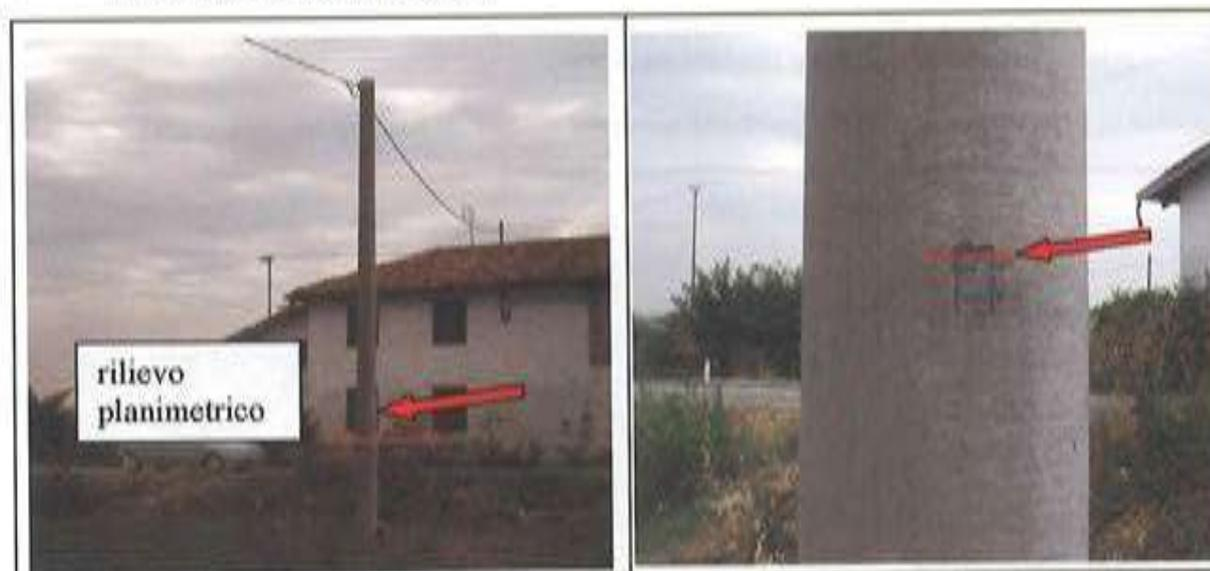
Nella foto di sinistra si evidenzia a che altezza (indicativa) battere l'asse del palo (che risulta leggermente inclinato), nella foto di destra (particolare) si evidenzia il limite superiore della targhetta metallica quale RA.
